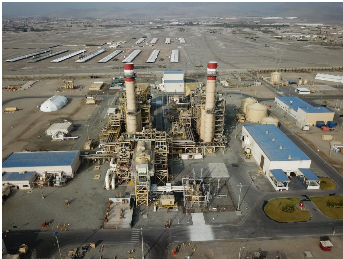
Imagen N° 3-2: Vista de la Central Termoeléctrica
