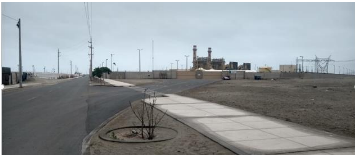
Imagen N° 3-3: Vista de la parte frontal de la Central Termoeléctrica
