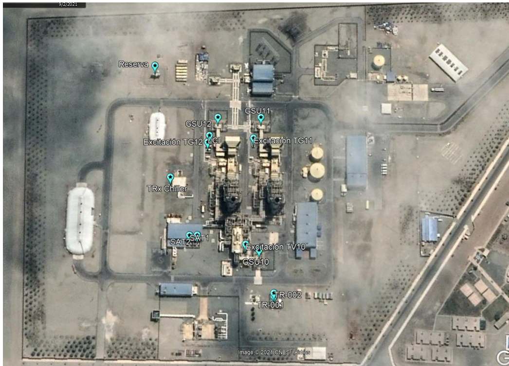
Ubicación referencial de los equipos a los cuales se les realizo el análisis cromatográfico
